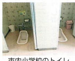
市内小学校のトイレ
