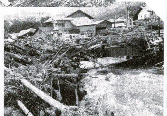
小本川には大量の流木が流れ着き、川の水が溢れ周囲の住宅地を襲いました
