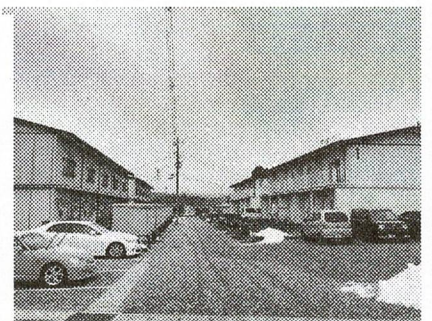
衣川・池田市営住宅
