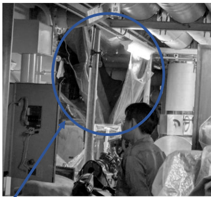
地下ボイラー室の雨漏り処理状況 ブルーシート
