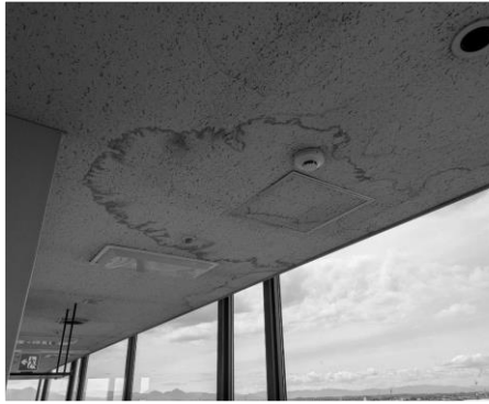
7階 天井の雨漏りの跡
